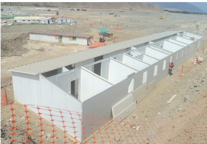
Edificio en proceso de techado
